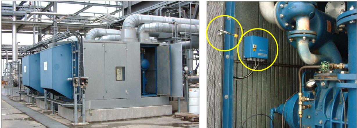
Bild 20: Schallschutzgehäuse mit Onlinesystem und Messmikrofon zur mobilen Messung
